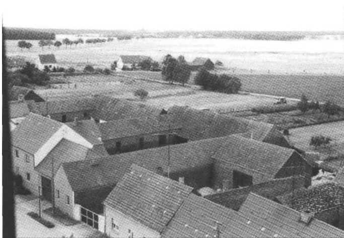
Gården i Ruhlsdorf ses her, stuehuset er det toetagers hus der ses til venstre i billedet
