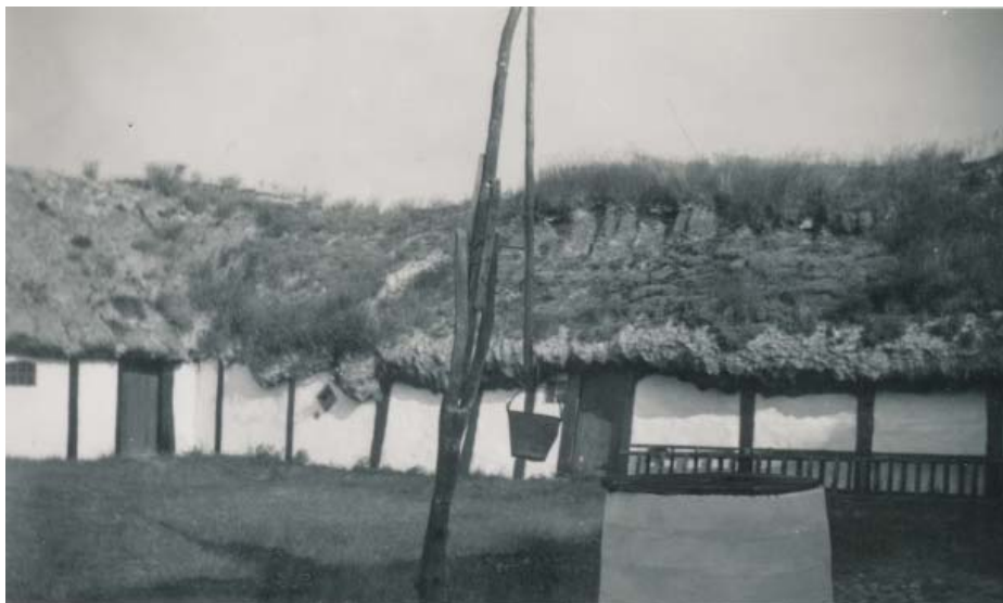
Museumsgården på Læsø er en af de gamle gårde, som er tækket med tang, dette billede er fra 1957, vippearmen til at hente vand op fra brønden, står der stadig.
